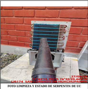
FOTO LIMPIEZA Y ESTADO DE SERPENTIN DE UC
