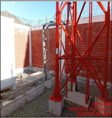
Foto Panorámica del Interior del Site
