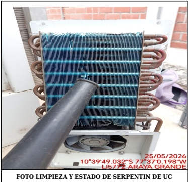
FOTO LIMPIEZA Y ESTADO DE SERPENTIN DE UC
