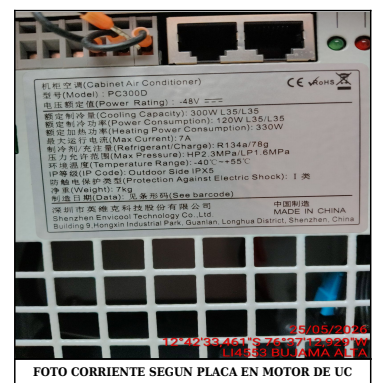
FOTO CORRIENTE SEGUN PLACA EN MOTOR DE UC
