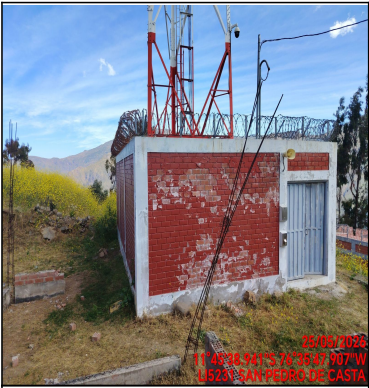
Pozo a tierra
