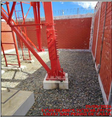
Foto Panorámica del Interior del Site
