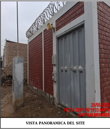
VISTA PANORAMICA DEL SITE
