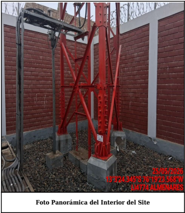
Foto Panorámica del Interior del Site
