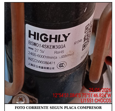
FOTO CORRIENTE SEGUN PLACA COMPRESOR
