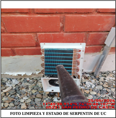
FOTO LIMPIEZA Y ESTADO DE SERPENTIN DE UC
