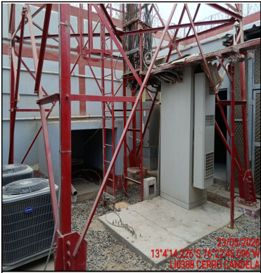
Foto Panorámica del Interior del Site
