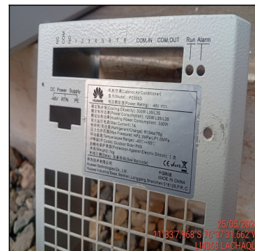
FOTO CORRIENTE SEGUN PLACA EN MOTOR VENTILADOR
