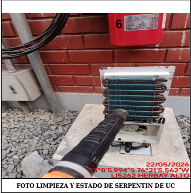
FOTO LIMPIEZA Y ESTADO DE SERPENTIN DE UC
