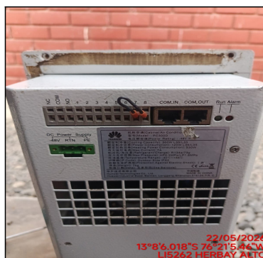
FOTO CORRIENTE REAL EN MOTOR VENTILADOR
