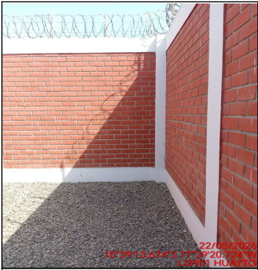
Foto Panorámica del Interior del Site
