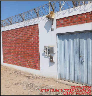
Pozo a tierra
