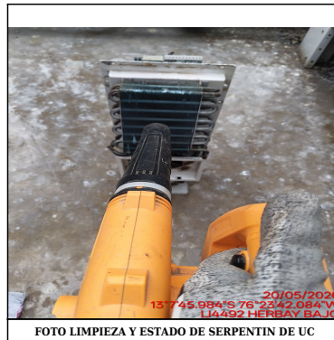
FOTO LIMPIEZA Y ESTADO DE SERPENTIN DE UC
