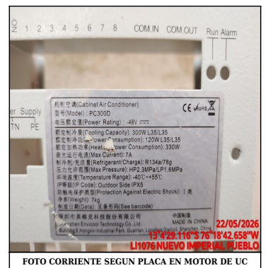
FOTO CORRIENTE SEGUN PLACA EN MOTOR DE UC
