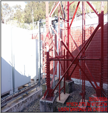
Foto Panorámica del Interior del Site
