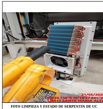
FOTO LIMPIEZA Y ESTADO DE SERPENTIN DE UC
