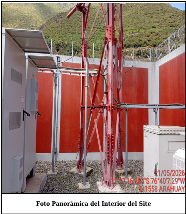
Foto Panorámica del Interior del Site
