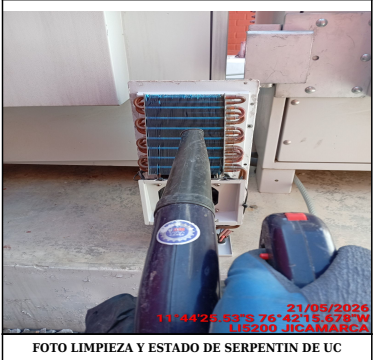
FOTO LIMPIEZA Y ESTADO DE SERPENTIN DE UC
