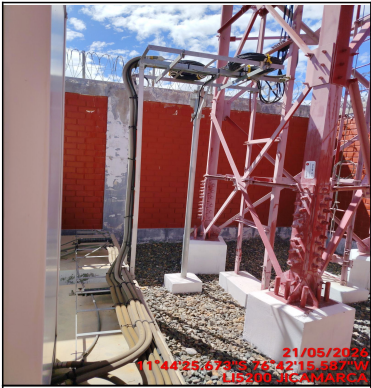
Foto Panorámica del Interior del Site
