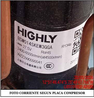
FOTO CORRIENTE SEGUN PLACA COMPRESOR
