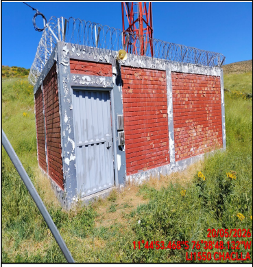
Pozo a tierra
