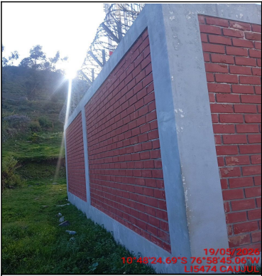
Pozo a tierra
