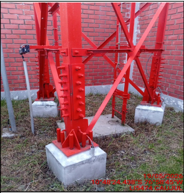
Foto Panorámica del Interior del Site
