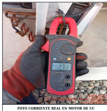
FOTO CORRIENTE REAL EN MOTOR DE UC
