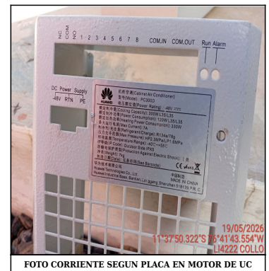
FOTO CORRIENTE SEGUN PLACA EN MOTOR DE UC
