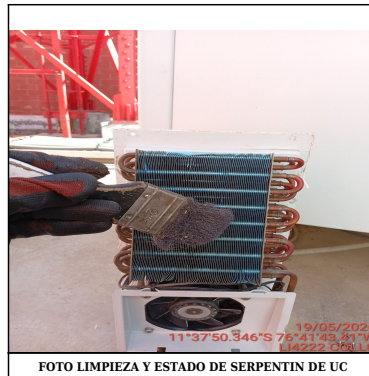
FOTO LIMPIEZA Y ESTADO DE SERPENTIN DE UC
