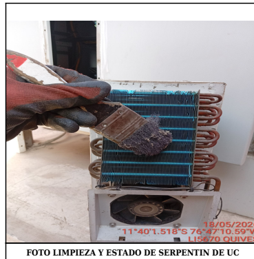
FOTO LIMPIEZA Y ESTADO DE SERPENTIN DE UC
