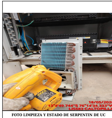
FOTO LIMPIEZA Y ESTADO DE SERPENTIN DE UC
