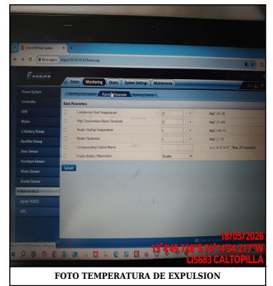
FOTO TEMPERATURA DE EXPULSION
