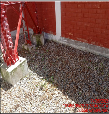
Foto Panorámica del Interior del Site
