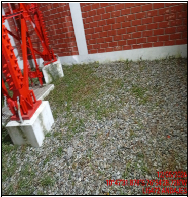
Foto Panorámica del Interior del Site
