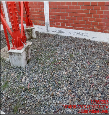
Foto Panorámica del Interior del Site
