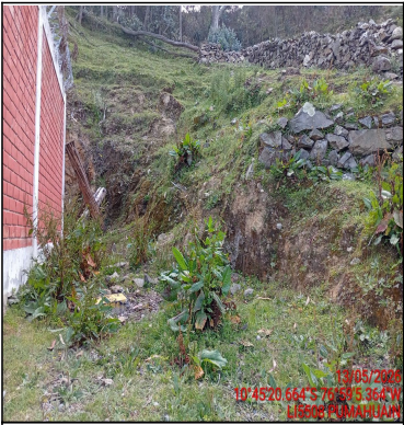
Pozo a tierra
