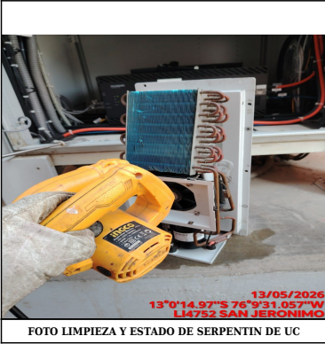
FOTO LIMPIEZA Y ESTADO DE SERPENTIN DE UC
