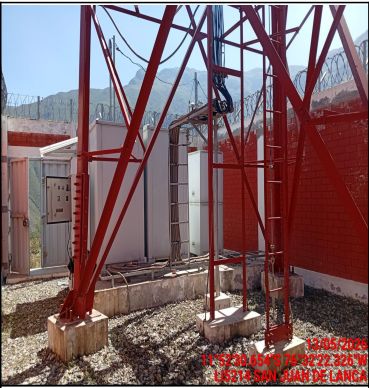
Foto Panorámica del Interior del Site
