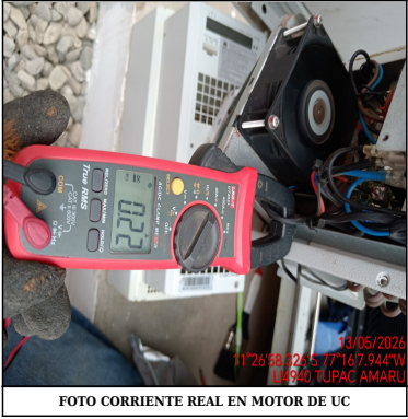
FOTO CORRIENTE REAL EN MOTOR DE UC
