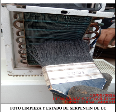
FOTO LIMPIEZA Y ESTADO DE SERPENTIN DE UC
