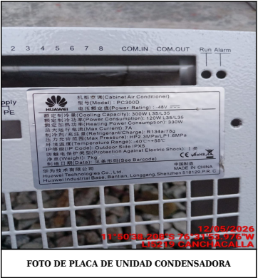
FOTO DE PLACA DE UNIDAD CONDENSADORA
