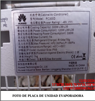
FOTO DE PLACA DE UNIDAD EVAPORADORA
