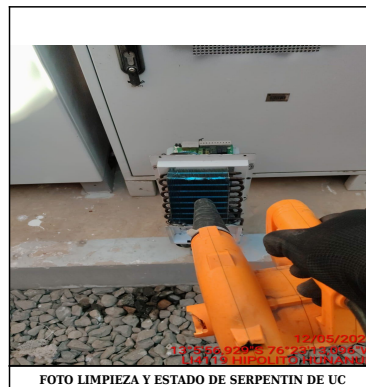
FOTO LIMPIEZA Y ESTADO DE SERPENTIN DE UC
