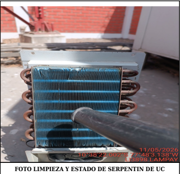
FOTO LIMPIEZA Y ESTADO DE SERPENTIN DE UC
