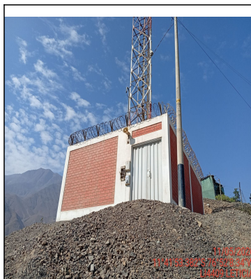
VISTA PANORAMICA DEL SITE
