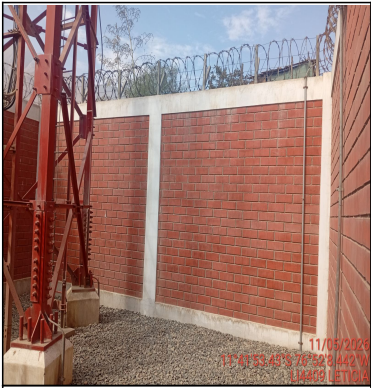
Foto Panorámica del Interior del Site
