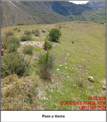
Pozo a tierra
