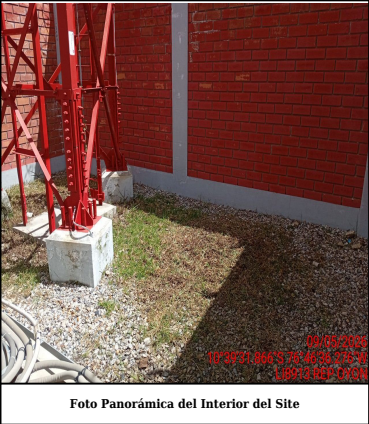
Foto Panorámica del Interior del Site
