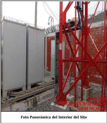
Foto Panorámica del Interior del Site
