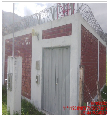
VISTA PANORAMICA DEL SITE
