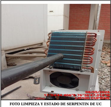
FOTO LIMPIEZA Y ESTADO DE SERPENTIN DE UC
