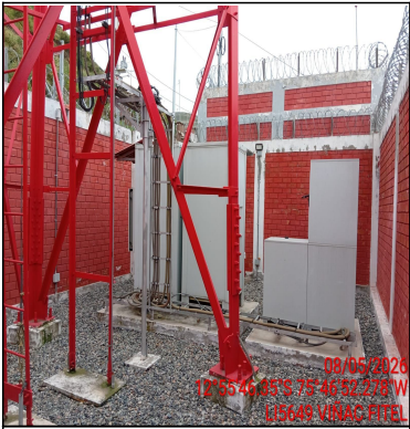
Foto Panorámica del Interior del Site
