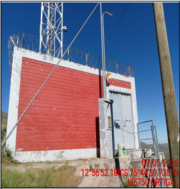
Pozo a tierra
