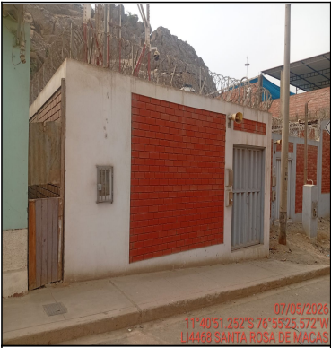
Pozo a tierra
