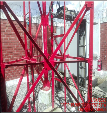
Foto Panorámica del Interior del Site
