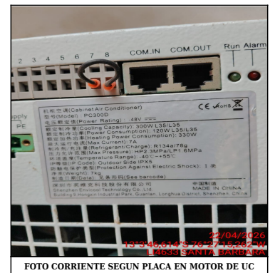
FOTO CORRIENTE SEGUN PLACA EN MOTOR DE UC
