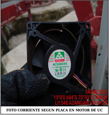
FOTO CORRIENTE SEGUN PLACA EN MOTOR DE UC
