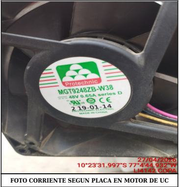
FOTO CORRIENTE SEGUN PLACA EN MOTOR DE UC
