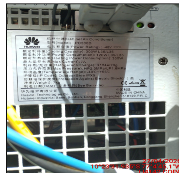
FOTO DE PLACA DE UNIDAD CONDENSADORA
