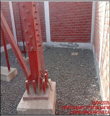
Foto Panorámica del Interior del Site
