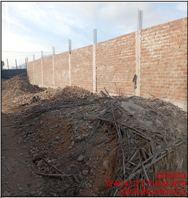
Pozo a tierra
