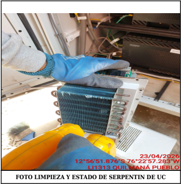
FOTO LIMPIEZA Y ESTADO DE SERPENTIN DE UC
