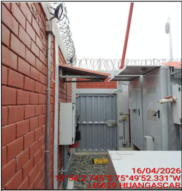
Foto Panorámica del Interior del Site
