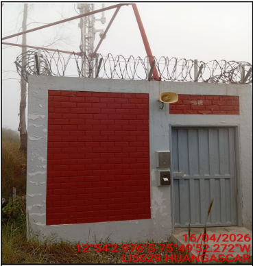
Pozo a tierra
