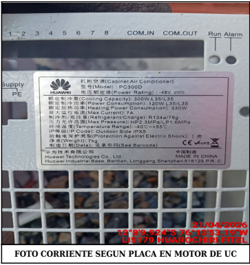
FOTO CORRIENTE SEGUN PLACA EN MOTOR DE UC
