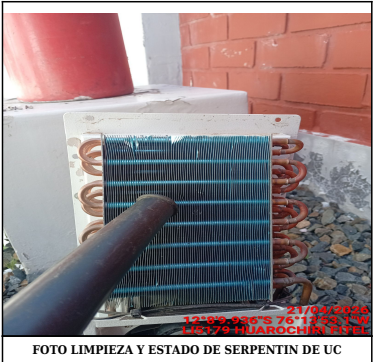
FOTO LIMPIEZA Y ESTADO DE SERPENTIN DE UC
