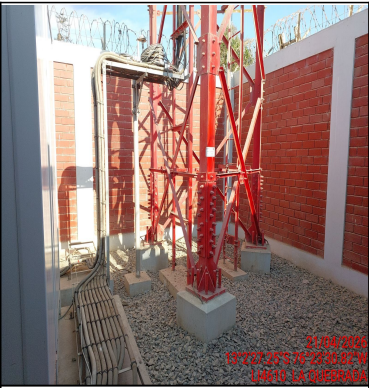
Foto Panorámica del Interior del Site
